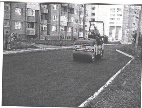
Асфальтирование дворовых проездов
