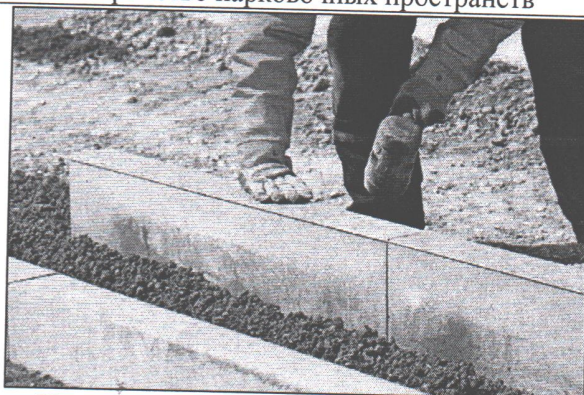
Установка или замена бордюрного камня
